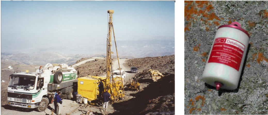
Fig. 2: Perforación en el picacho del Veleta y datalogger tipo UTL1 utilizado.
