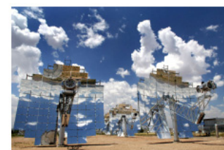
Figura 5. Espejos solares Stirling. Estos bonitos concentradores producen una potencia por unidad de superficie ocupada de 14 W/m 2 . Foto por cortesía de Stirling Energy Systems. www.stirlingenergy.com
